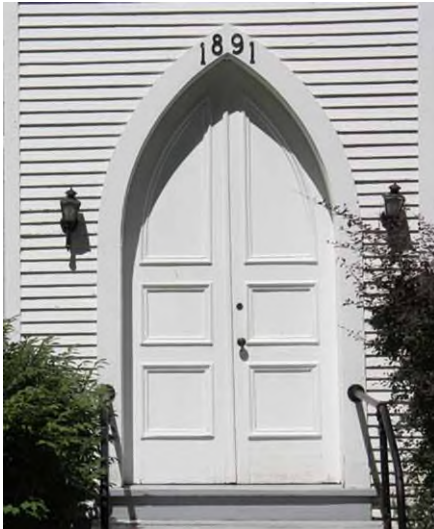
Porte en menuiserie d'assemblage en arc d'ogive, typiquement néogothique. Église unie, 63, chemin de Magoon Point. IMG_8977.jpg
