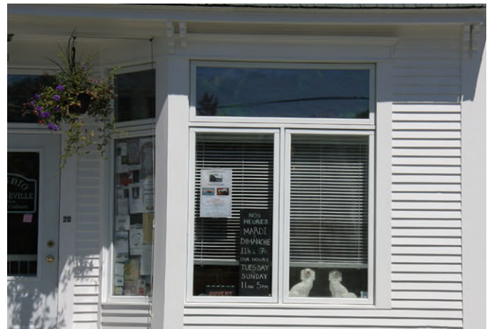
Fenêtre à battants et à imposte, typique du début du 20 e siècle. 20, carré Copp. IMG_9011.jpg
