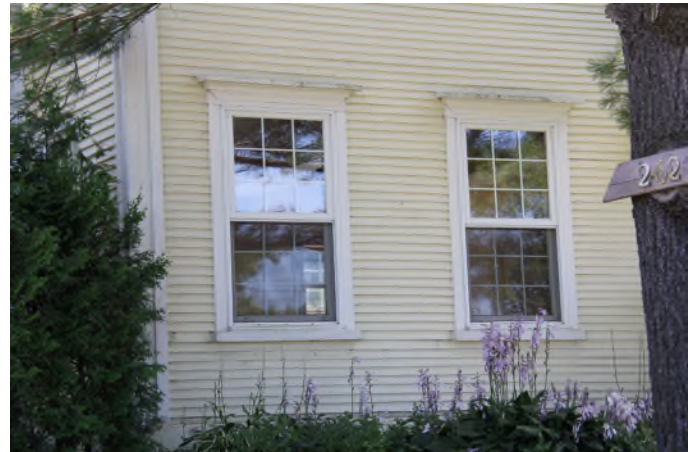
Autre usage fort intéressant de planche à clin étroite au 2621, chemin de Fitch Bay. IMG _8961.jpg
