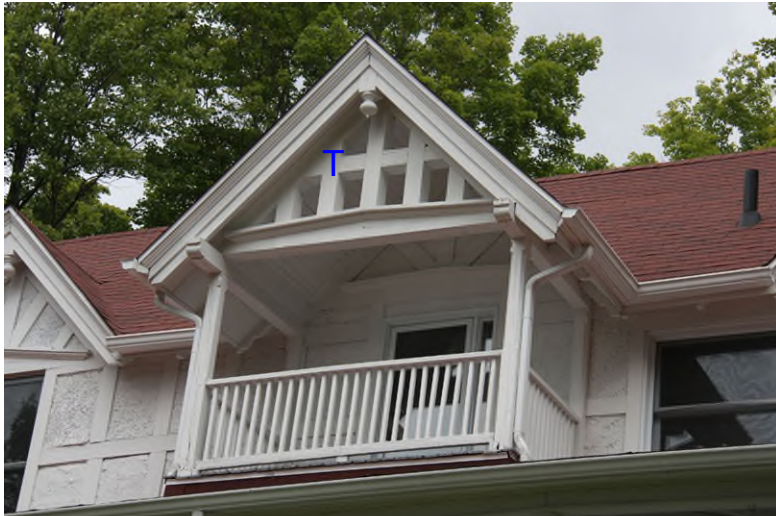
Balcon monumental. Notez l'exceptionnel tympan ajouré (T) du fronton. 4615, chemin de Georgeville. IMG _8630.jpg
