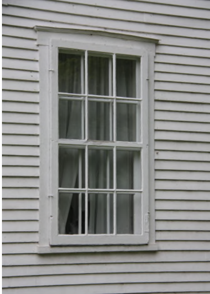
Contre-fenêtre à douze petits carreaux au 4652, chemin de Georgeville, érigé vers 1821. IMG_8663.jpg
