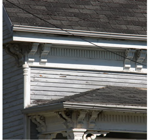
Consoles doubles très ornées d'une corniche à denticules. 812, chemin Sheldon. IMG_8858.jpg
