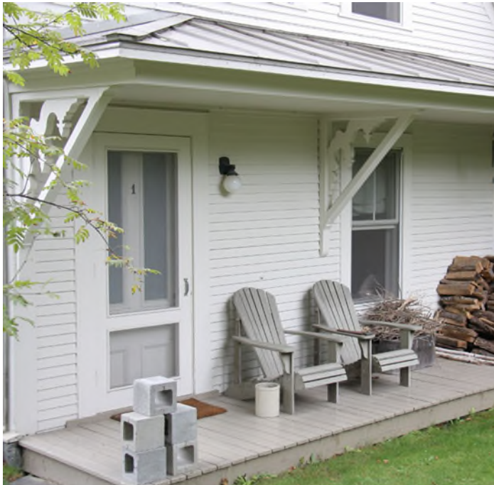
Équerres ouvragées supportant le toit de la galerie du 43, chemin de Magoon Point. IMG_8701.jpg
