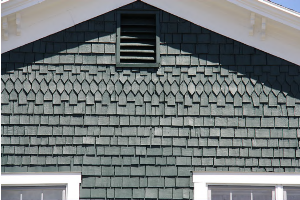
Exemple de revêtement de bardeau de cèdre, dont une partie est à motifs géométriques. 20, carré Copp. IMG_9009.jpg
