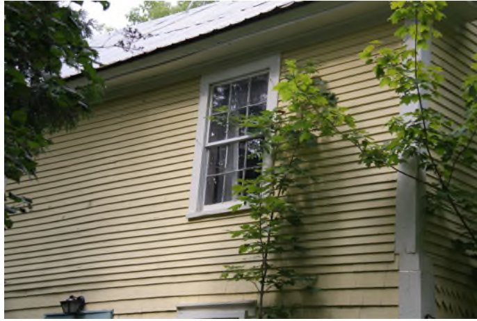
Autre exemple de fenêtre à guillotine à douze petits carreaux au 32, chemin Channell, un édifice qui daterait de 1803. IMG_8761.jpg
