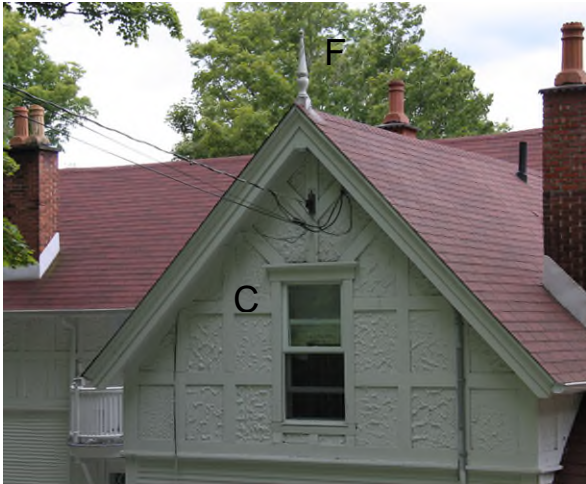
Colombages décoratifs (C) et faîteau (F) au 4615, chemin de Georgeville. IMG_8626.
