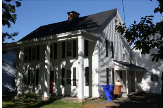
Exemple de maison de style géorgien. 4659, chemin de Georgeville. IMG_8813.jpg
