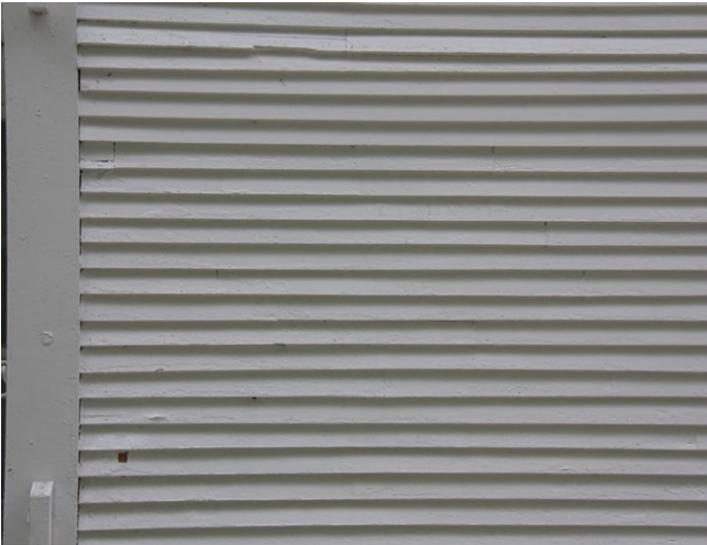
Exemple de revêtement de planche à clin très étroite, typique de l'Estrie et de Stanstead en particulier. 4615, chemin de Georgeville. IMG _8634.jpg
