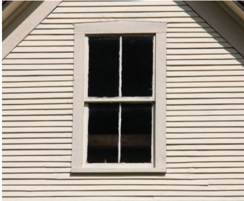
Exemple de fenêtre à guillotine à grands carreaux. Le revêtement mural est en planche à clin. 70, chemin de Magoon Point (1878). IMG_8719.jpg
