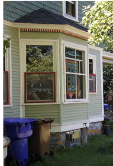
Logette à trois pans avec contre-fenêtres appuyées sur le cadre (sans feuillure). 2749, chemin de Fitch Bay. IMG _8933.jpg
