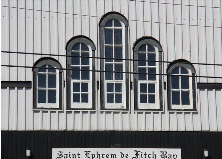
Jeu de fenêtres en arc plein cintre sur la façade principale de l'église Saint-Éphrem de Fitch Bay, dont le rôle principal est d'éclairer la nef. 380, chemin Remick. IMG_8899.jpg
