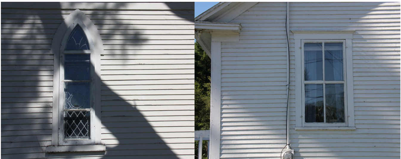
Chambranle dont la partie supérieure épouse la forme en arc brisé (ou en ogive) de la fenêtre qu'il entoure. Fitch Bay Anglican Church, chemin Sheldon. IMG_8870.jpg
