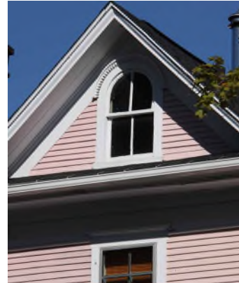
Fenêtre à guillotine à grands carreaux, en arc plein cintre, éclairant ici une lucarne triangulaire. 71, chemin Channell (1889). IMG_8794.jpg
