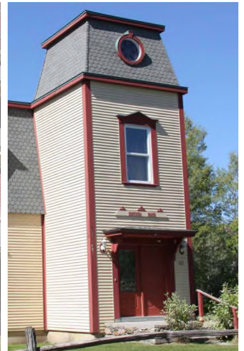
Tourelle d'inspiration Second Empire du 412, chemin Remick. IMG_8896.jpg
