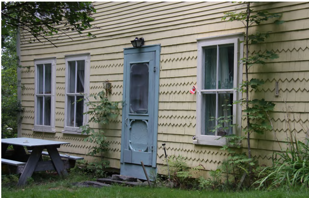
Autre revêtement de bardeau de bois, ici découpé en partie en dents de scie et utilisé conjointement avec de la planche à clin. 32, chemin Channell. IMG_8759.jpg
