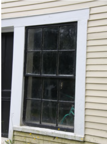
Exemple de fenêtre à guillotine à douze petits carreaux au 2, chemin McGowan, érigé vers 1824. IMG_8653.jpg
