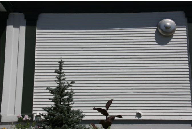
La tradition d'utiliser la planche à clin étroite s'est répandue assez tardivement, comme en témoigne le Murray Memorial Center construit en 1934 et revêtu de ce matériau. 4680, chemin de Georgeville. IMG _9075.jpg
