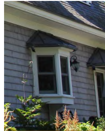
Fenêtre en saillie. Contrairement aux logettes, on ne peut pas y pénétrer. 40, carré Copp. IMG _9019.jpg
