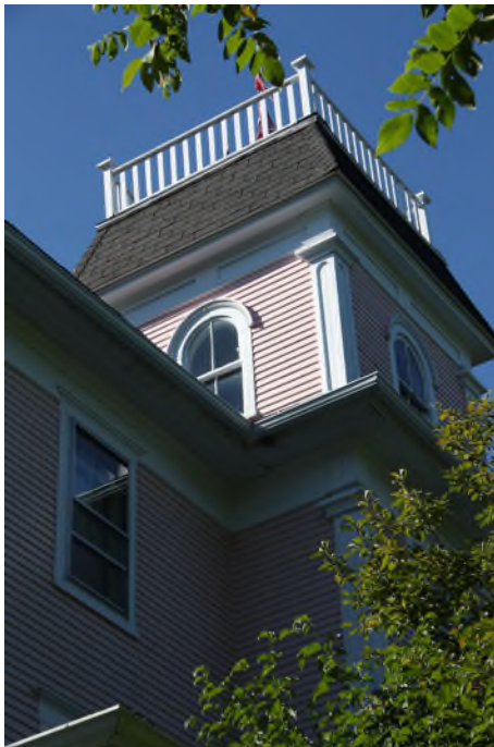
Sommet d'une tourelle surmontée d'un garde-corps de couronnement. Avon Dolloff Boarding House, 71, chemin Channell. IMG_8847.jpg
