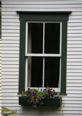
Autre exemple de fenêtre à guillotine à grands carreaux, avec chambranle et corniche. 44, chemin de Magoon Point (1884). IMG_8728.jpg
