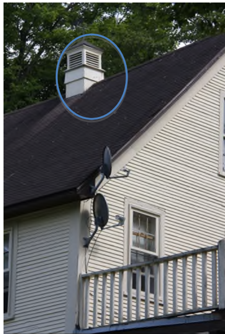
Lanternon au sommet du toit du 70, chemin de Magoon Point. IMG_8723.jpg
