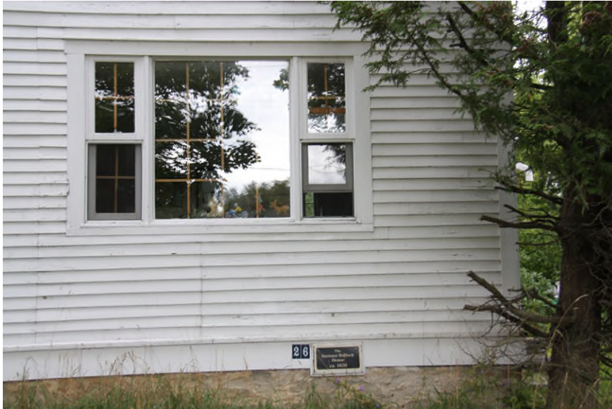
Exemple de fenêtre à baies latérales ; celles-ci sont à guillotine. 26, carré Copp. IMG_8671.jpg
