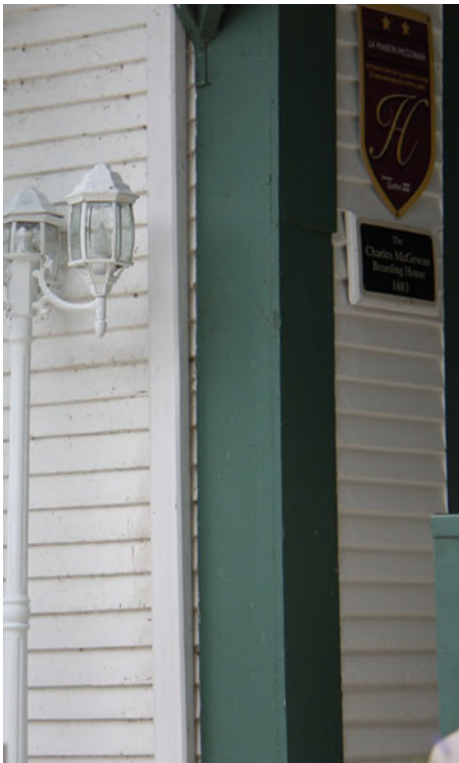
Large planche cornière sur laquelle s'aboutent les planches à clin du revêtement. Maison McGowan, 51, carré Copp. IMG_8679.jpg
