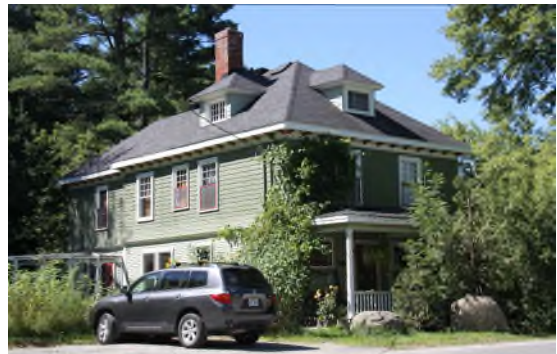
Exemple de maison cubique. 2743, chemin de Fitch Bay. IMG_8928.jpg
