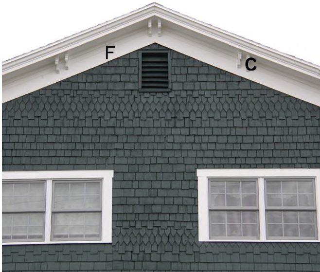
Consoles (C) doubles, en bordure de la saillie de rive (rebord du toit). Avec les frises (F), les consoles composent une forme particulière de corniche. 20, carré Copp. IMG_8688.jpg
