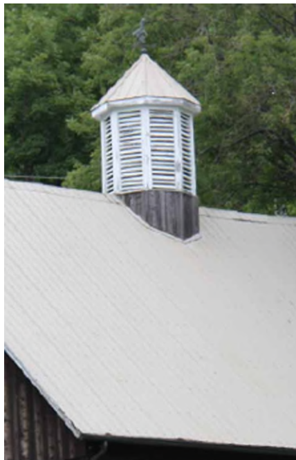
Lanternon de ventilation de la grange-étable bâtie pour Sewell Coop en 1879. Chemin McGowan. IMG_8801.jpg
