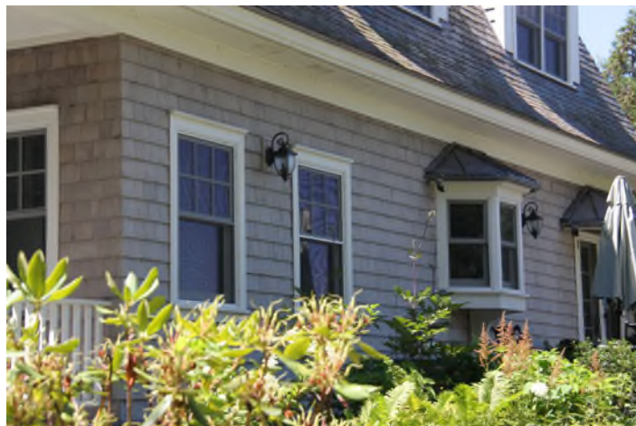
Autre intéressante utilisation, relativement tardive, de bardeau de bois sur cet édifice de style Arts and Crafts. 40, carré Copp. IMG_9019.jpg
