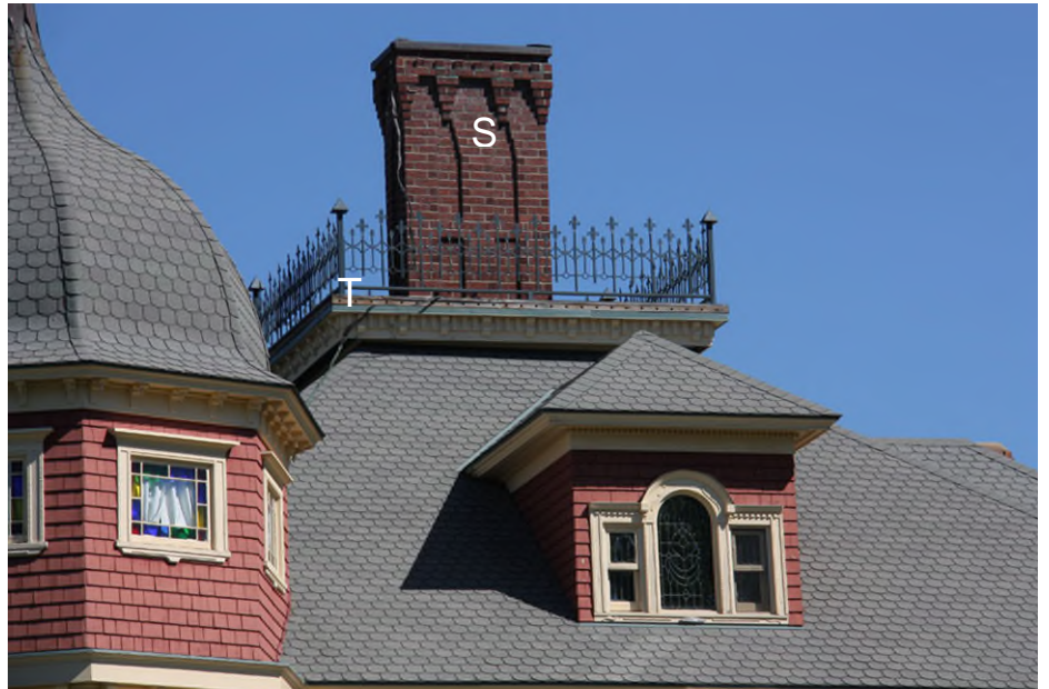
Souche (S) de cheminée ornée au sommet du toit pyramidal du château Rider. Une terrasse faîtière entoure la cheminée (le garde-corps est récent). La lucarne est de style palladien. 411, chemin Remick. IMG _8892.jpg
