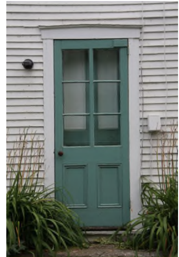
Porte en menuiserie d'assemblage avec vitrage à carreaux. 4652, chemin de Georgeville. IMG_8793.jpg
