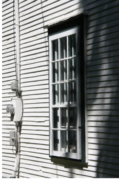
Contre-fenêtre à quinze petits carreaux du 59, chemin de Magoon Point, construit en 1823. IMG_8981.jpg
