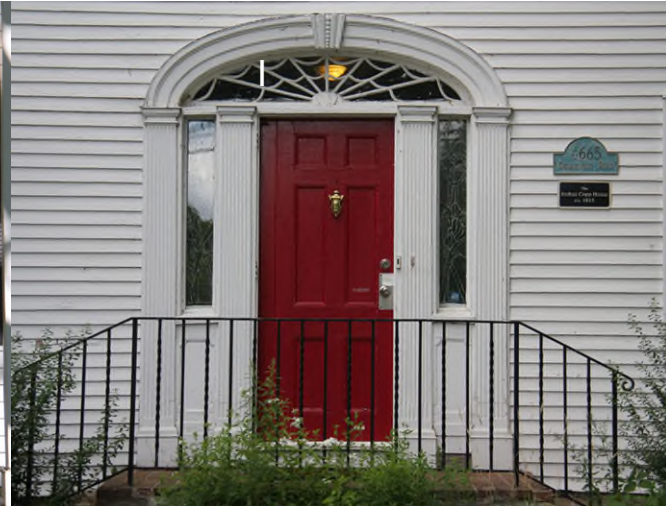
Autre exemple de porte en menuiserie d'assemblage mise en valeur par des baies latérales, des pilastres cannelés et une imposte (I) en anse de panier de style Adam. 4665, chemin de Georgeville. IMG_8795.jpg
