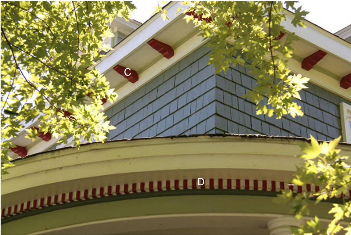
Consoles (C) sous le rebord du toit et, au premier plan, des denticules (D) longeant la bordure du toit de la galerie. 2749, chemin de Fitch Bay. IMG_8935.jpg
