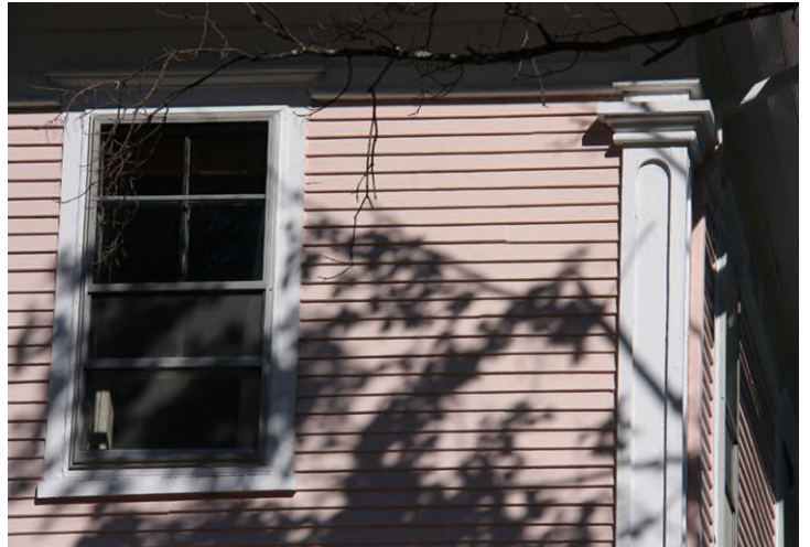
Parement de planche à clin étroite, délimitée par une planche cornière à relief. 71, chemin de Magoon Point. IMG _8843.jpg
