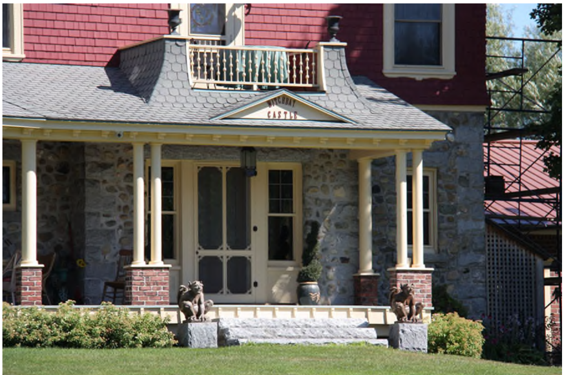
Une partie du portique du château Rider avec ses colonnes doubles sur socle supportant un toit orné d'une corniche à consoles. 411, chemin Remick. IMG _8893.jpg
