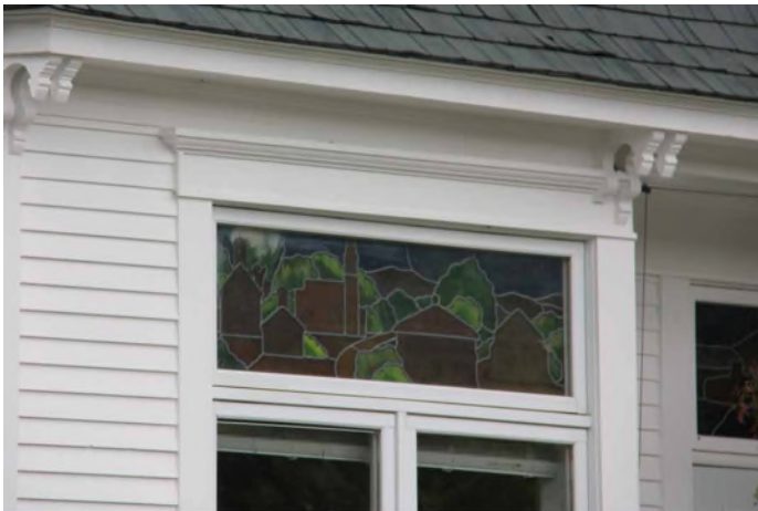
Vitraux dans l'imposte surmontant les ouvertures du rez-de-chaussée du 20, carré Copp. IMG_8690.jpg
