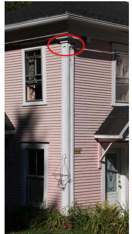
Planche cornière à relief, surmontée d'un chapiteau à son sommet. 71, chemin Channell. IMG_8842.jpg
