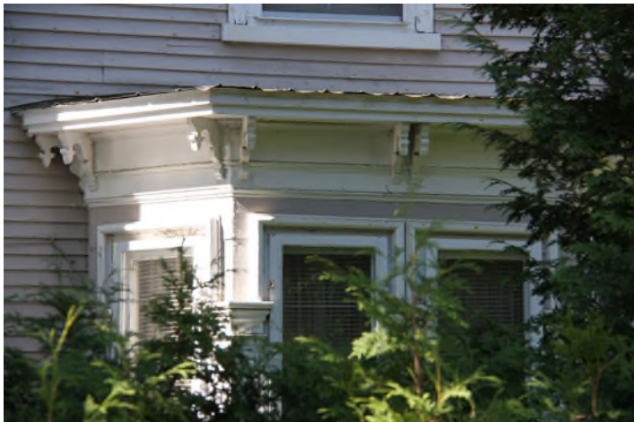
Partie supérieure très ornée d'une logette, où l'on retrouve des consoles doubles et une corniche. 777, chemin Sheldon. IMG _8876.jpg
