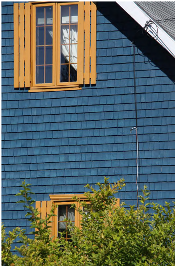
Bardeau de bois simple dont l'âge est difficile à déterminer. 811, chemin Sheldon. IMG_8868.jpg
