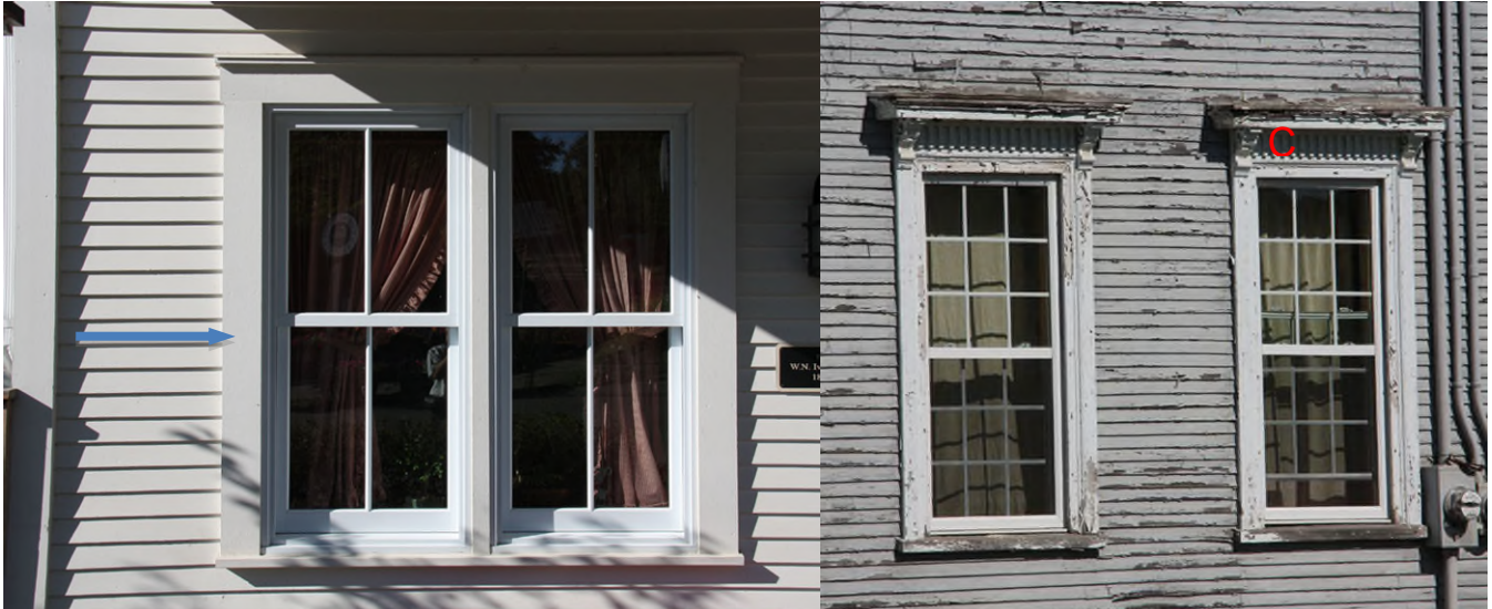
Chambranle plat, de facture simple, entourant des fenêtres à guillotine jumelées au 4675, chemin de Georgeville. IMG_8808.jpg
