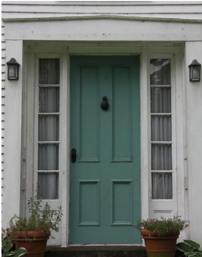
Autre porte en menuiserie d'assemblage, dotée ici de baies latérales. 4652, chemin de Georgeville. IMG_8662.jpg
