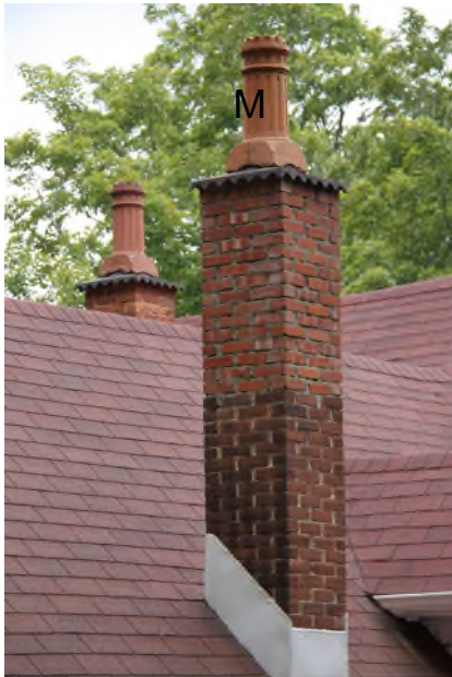
Mitrons (M) ornés surmontant les souches de cheminée en brique. 4615, chemin de Georgeville. IMG _8635.jpg
