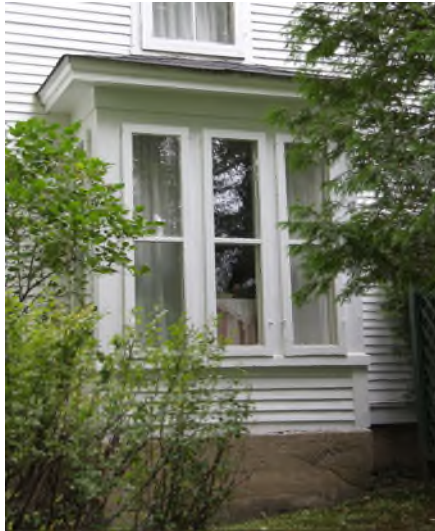
Autre exemple de logette, dont la forme est rectangulaire. 4653, chemin de Georgeville. IMG _8665.jpg
