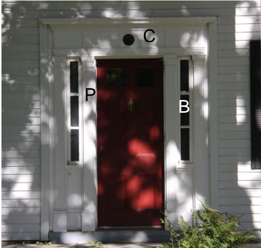
Exemple de porte en menuiserie d'assemblage avec corniche ©, baies latérales (B) et pilastres cannelés (P). 4659, chemin de Georgeville. IMG_8815.jpg
